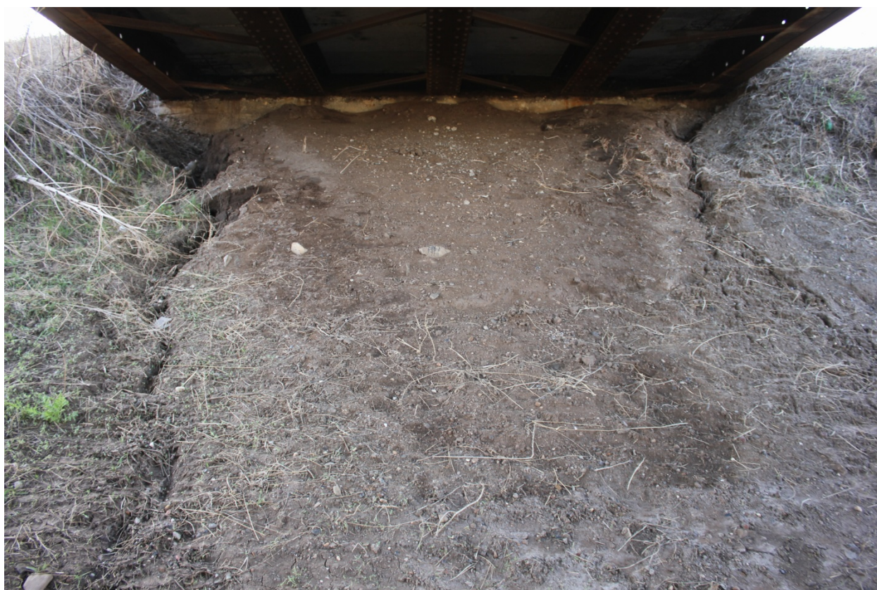
Рис.20 Опора №4. Отсутствие укрепления конуса
