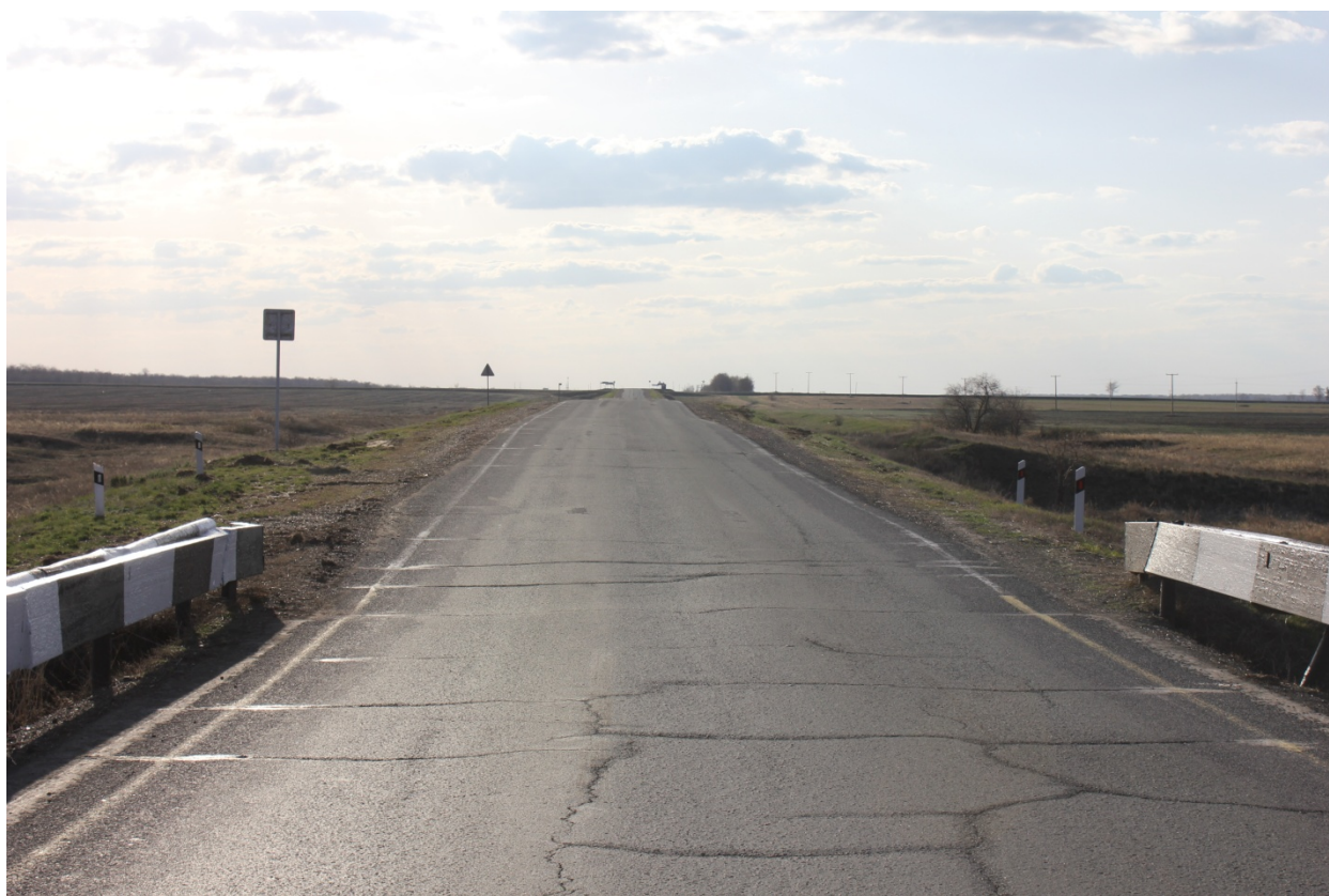
Рис.8 Подход КМ Трещины в покрытии
