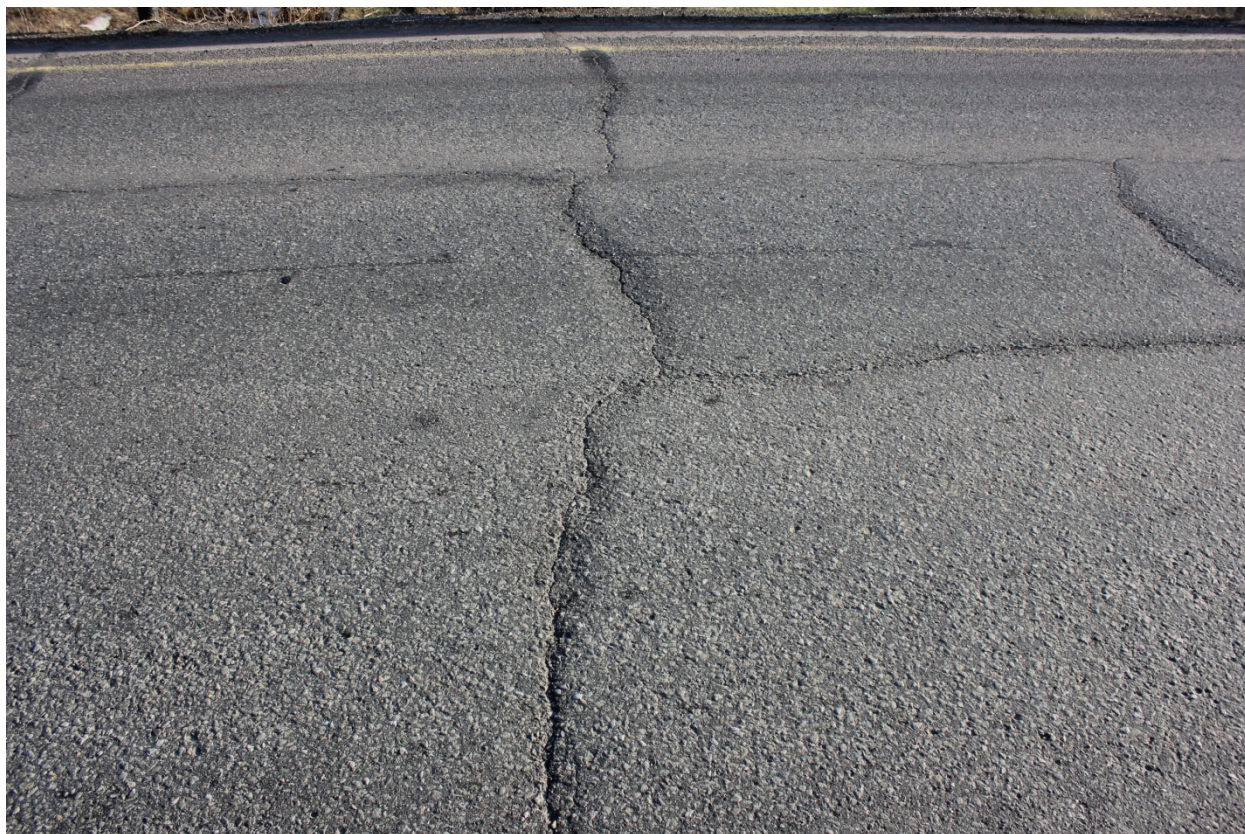
Рис.5 Деформационный шов на опоре №3 Трещины в покрытии
