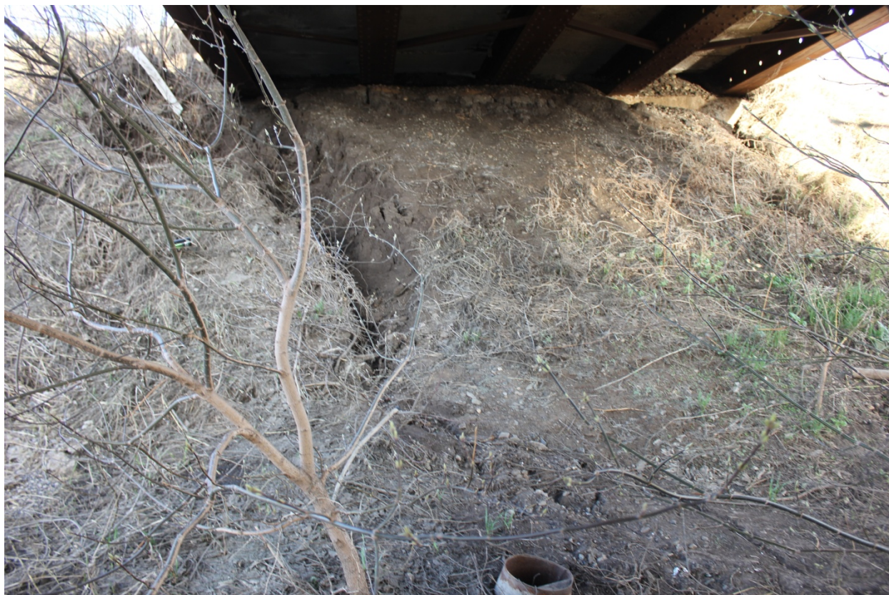
Рис.11 Опора №1. Вид от опоры №2 Размыв конуса
