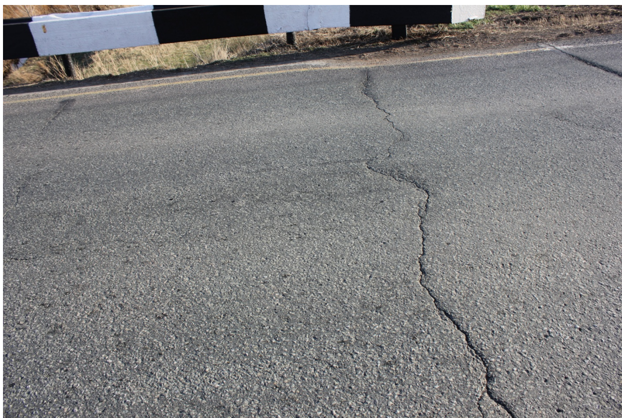
Рис.6 Деформационный шов на опоре №4 Трещины в покрытии
