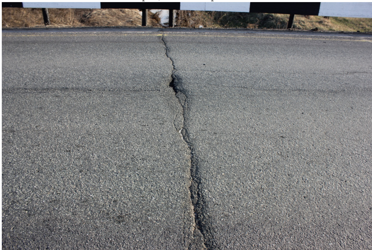
Рис.4 Деформационный шов на опоре №1 Трещины в покрытии
