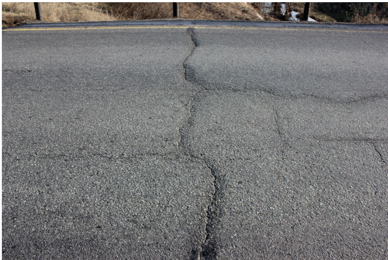
Рис.3 Деформационный шов на опоре №1 Трещины в покрытии
